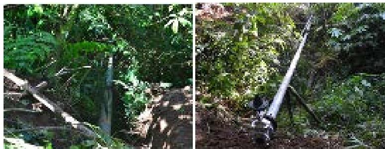
**Gambar 7.** Foto Pipa Penerjun/Penggerak
