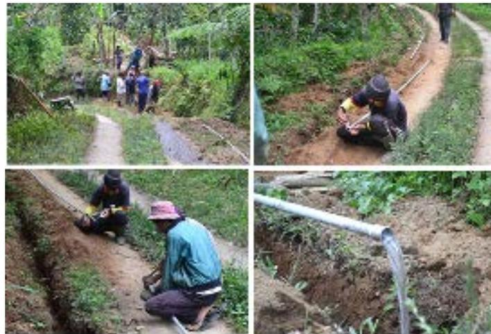
**Gambar 8.** Foto Pengerjaan Pemasangan Pipa Tekan/Pipa Pemompaan
