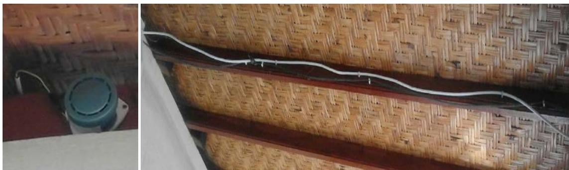
Gambar 3.3. Pemasangan bagian bel listrik dan kabel penghubungnya
