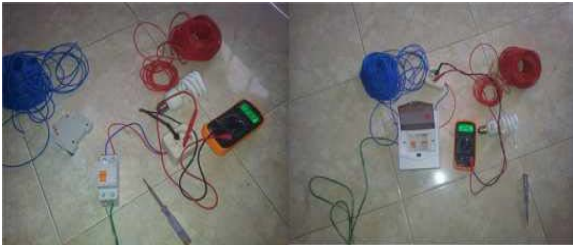
Gambar 3.3 Pemasangan peralatan pengaman arus sisa, ELCB 1 phase pada perlengkapan hubung bagi
