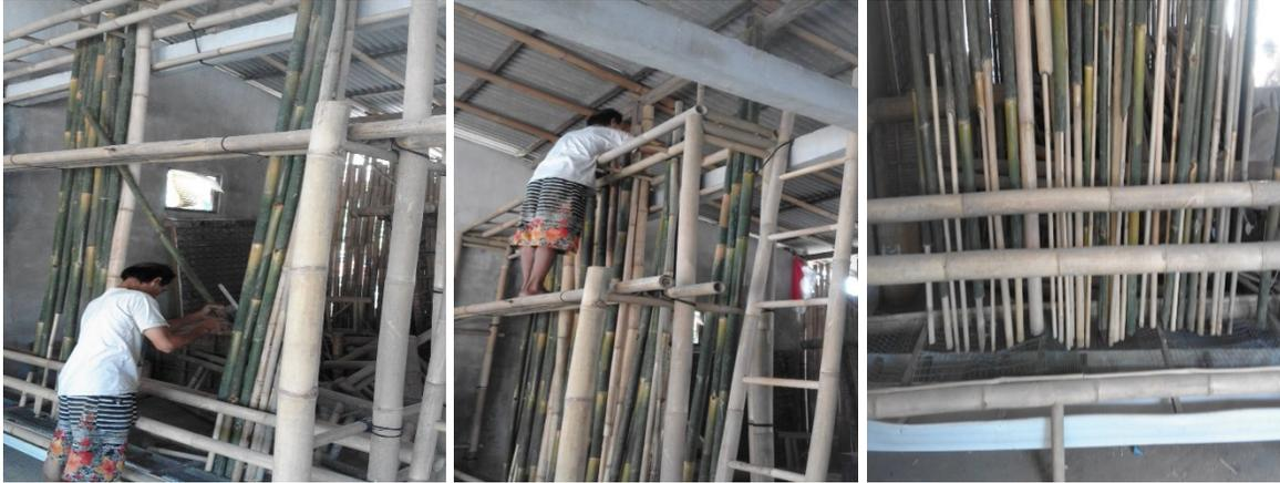
**Gambar 7.** Cara pengupasan kulit bagian dalam (atas) dan penempatan bambu yang akan diawetkan (bawah)
