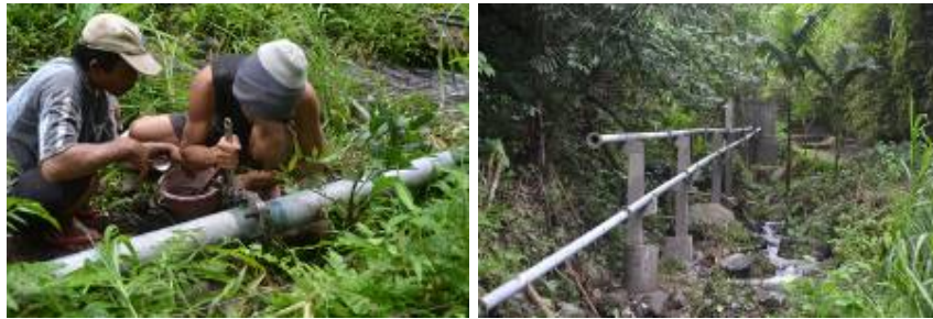
Gambar 12. Foto pengerjaan pipa penerjun/penggerak
