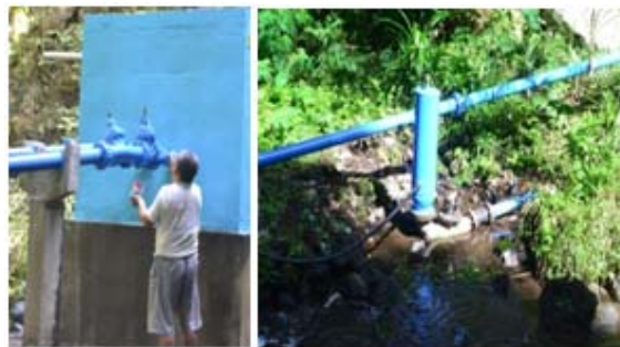
Gambar 19. Foto pengecatan pompa hydam dan pipa penggerak
