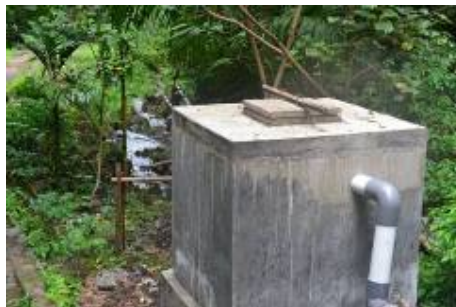
Gambar 11. Foto bak penerjun/penggerak
