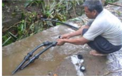
Gambar 15. Foto pemasangan koneksi pipa tekan.
