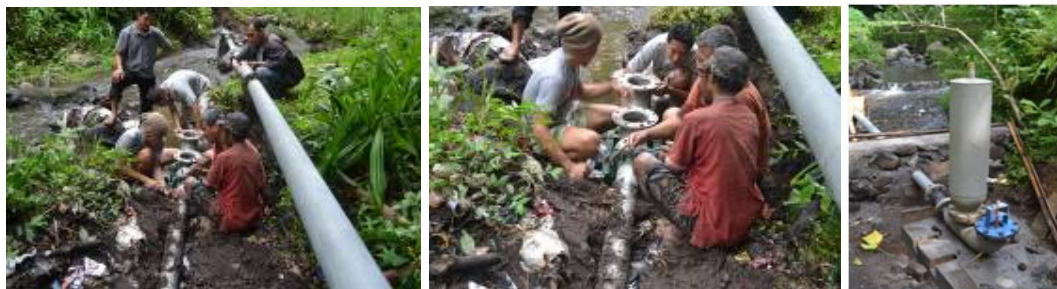
Gambar 13. Foto pengerjaan atau perakitan pompa hidram
