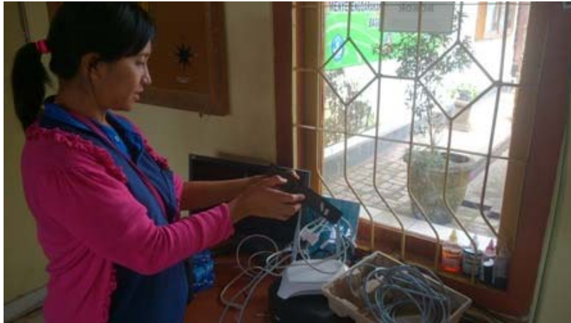
Gambar 4 Pemasangan Perangkat Jaringan pada Ruang Guru
