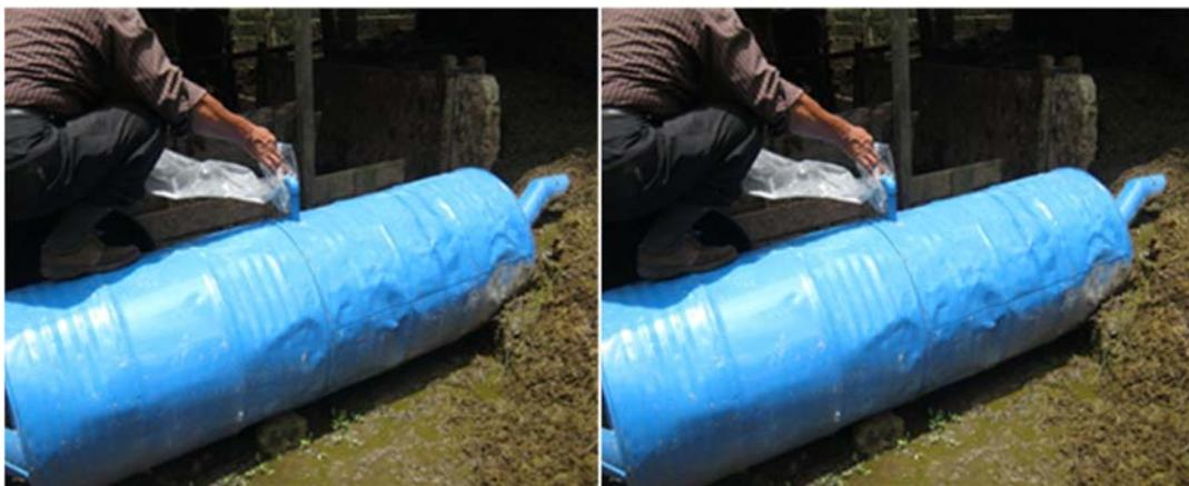
**Gambar 3.** Hasil Ujicoba Instalasi Biogas Tahap Awal, Terbukti dari Menggelembungnya Plastik Penampung Gas
