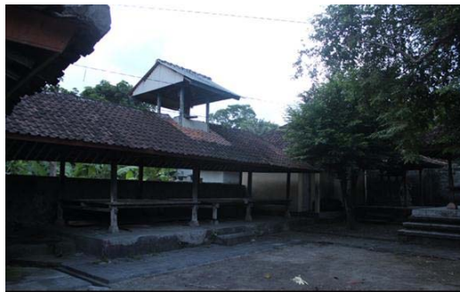
Gambar 1.1. Tempat kulkul yang menumpang pada atap salah satu bale (Sumber : Observasi, Pebruari 2015)
