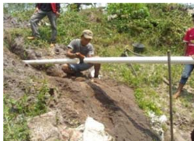
Gambar 5. Air sistem pemasangan pembuangan pipa
