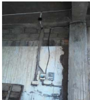
Gambar 3.4a. Realisasi Instalasi Penerangan dan Daya pada Lantai 1
