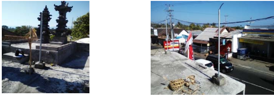
Gambar 3.4b. Realisasi Instalasi Penerangan dan Daya pada Lantai 2
