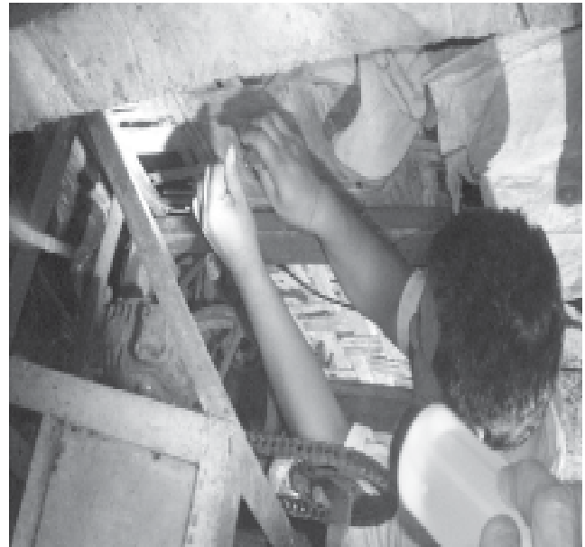
Gambar 5. Perakitan dan pemasangan sistem pengamanan
