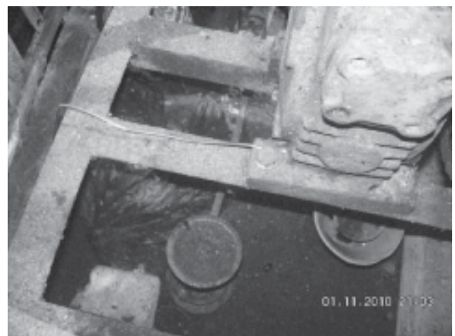
Gambar 7. Hasil demo instalasi sistem pembumian listrik yang aman
