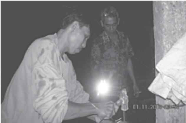
Gambar 3. Pemasangan arde type batang
