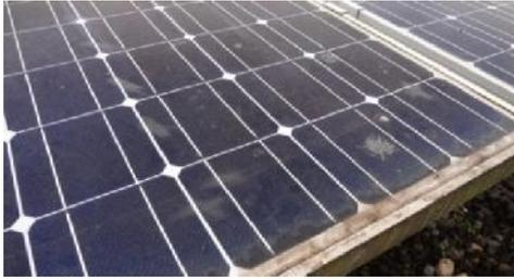
Gambar 14. *Shading* akibat pengotoran permukaan panel
