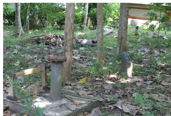
Gambar 2. Sumur Air Tanah
