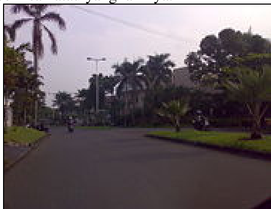
Gambar 3. Median Jalan Yang berbentuk Pulau Jalan
