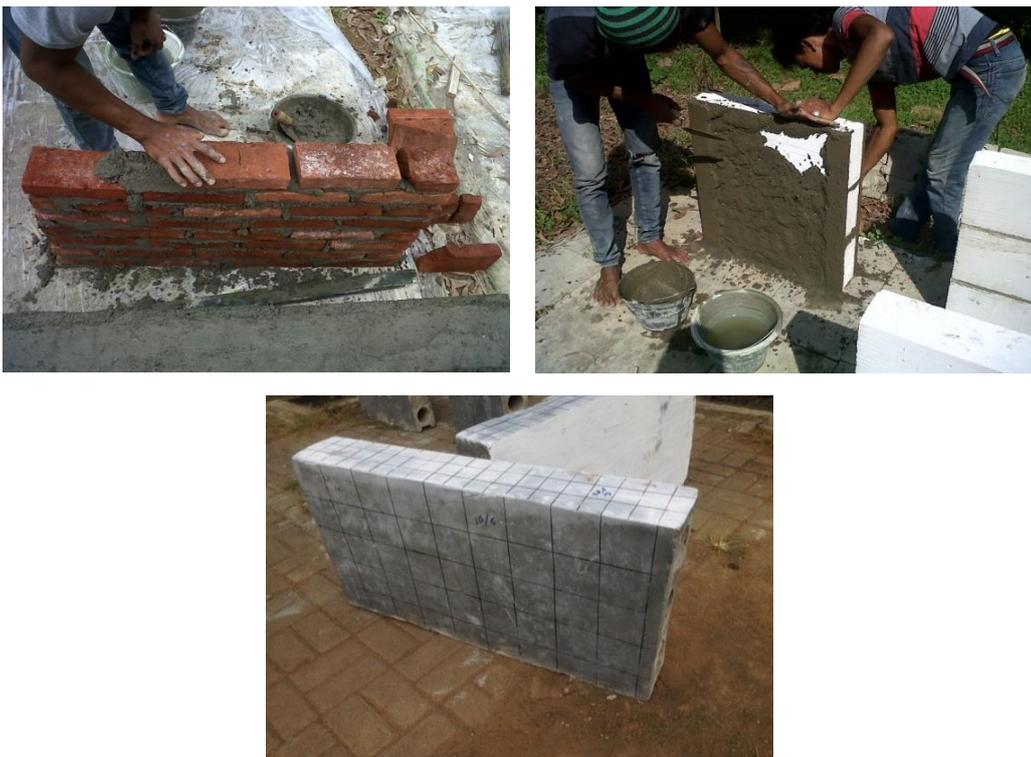
Gambar 3. Proses pembuatan benda uji dinding
