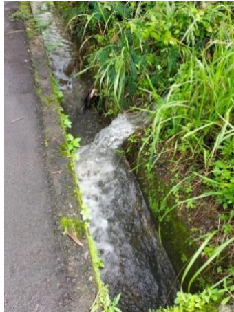
Gambar 3. Kondisi Saluran Irigasi di Subak Balangan pada Musim Hujan
