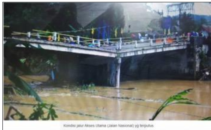
Gambar 5 Photo Jembatan Putra Pinggan (Kondisi Eksisting) Sumber: http://news.okezone.com/read/2016/10/10/525/1510652/jembatan-jalan-nasional-menuju-pangandaran-ditutup-total
