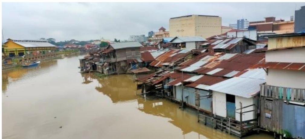
Gambar 3. Sungai Segmen Jembatan Perniagaan
