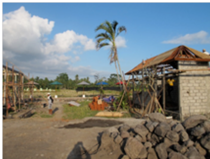
Gambar 2. Pembangunan rumah makan di wisata alam bija Desa Sayan
