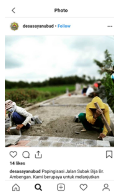
Gambar 3. Pembangunan paving block wisata alam bija Desa Sayan
