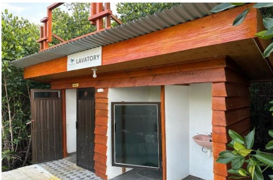
Gambar 4. Sarana Toilet Pada Lantebung Sumber 4. Dokumentasi Peneliti 2023
