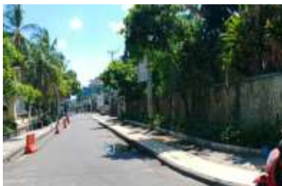
Gambar 2. Kondisi Jalan di Pantai Kuta
