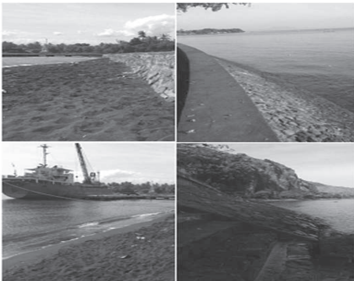
Gambar 5. Penanganan Abrasi Pantai Pesisir Barat Kabupaten Buleleng Sumber : Dokumentasi Lapangan, (2013)
