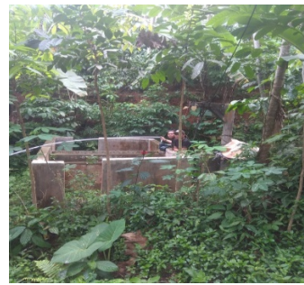
Gambar 6. Posisi Pompa dekat sumur sumber air Posisi alat penyiram dekat pompa
