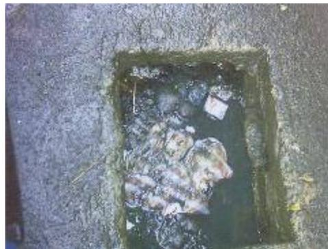
Gambar 7. Kondisi Saluran Air/Drainase Yang Tersumbat
