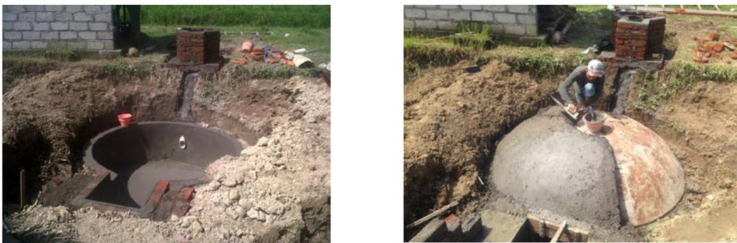
**Gambar 6.** Tahapan pengerjaan digester biogas
