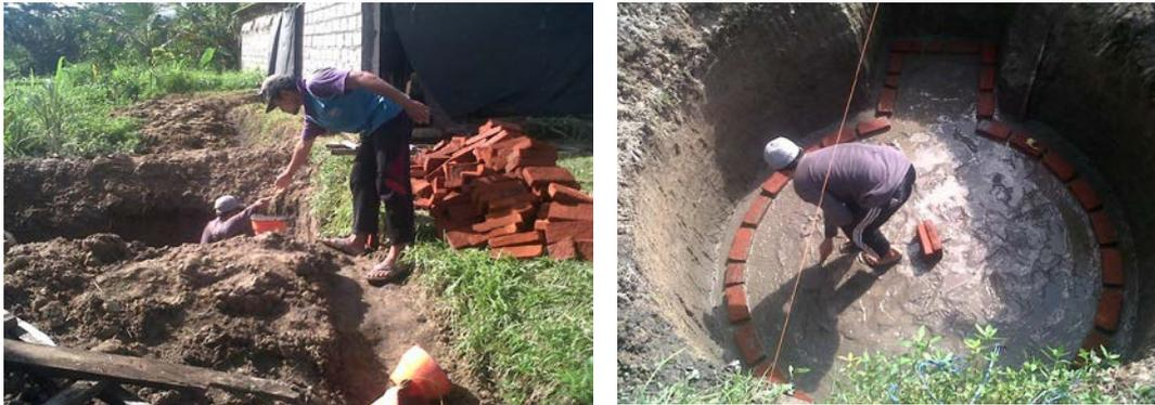
**Gambar 5.** Pemasangan bata untuk dasar dan kubah digester
