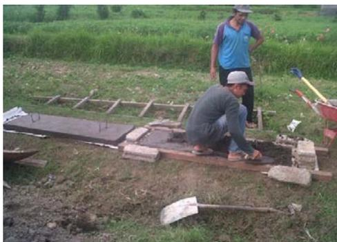
**Gambar 4a.** Pembuatan penutup beton
