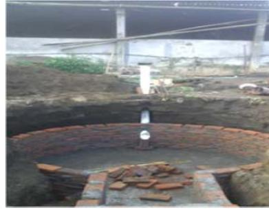
**Gambar 2b.** Pembuatan kubah beton dari bata
