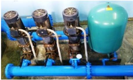
Gambar 1. Tiga unit pompa paralel
